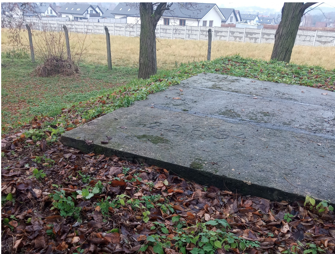
Fot. 2 Widok płyty żelbetowej zabezpieczającej dostęp do szybu.
