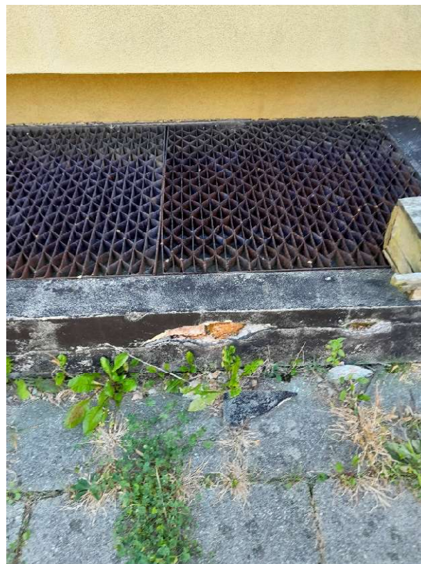
Okienko piwniczne – szacht doświetlenia
