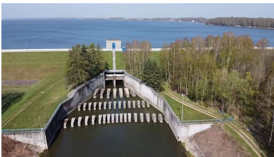
Fot. 1 Spust denny – zrzut w wysokości biologicznego.
