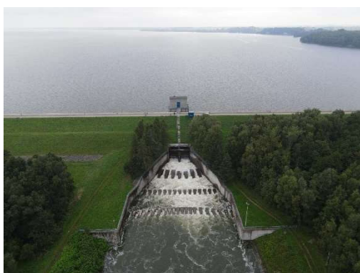
Fot. 2 – Spust denny – zrzut 50 m 3 /s.
