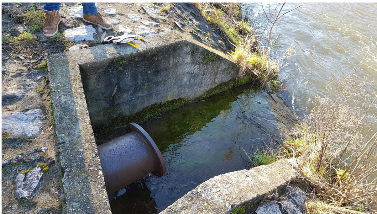
Widok nr 3. Wylot wody opadowej i ścieków przemysłowych do odbiornika (N3).
