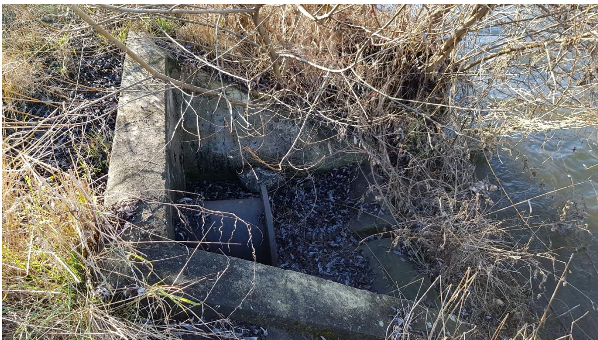
Widok nr 2. Wylot wody opadowej i ścieków przemysłowych do odbiornika (N2).
