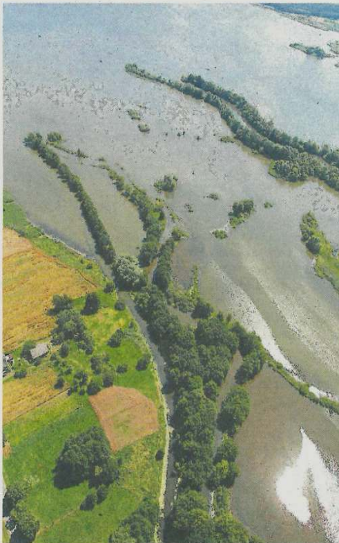
► Jezioro Goczałkowickie to rezerwar wody i nasze bezpieczeństwo
