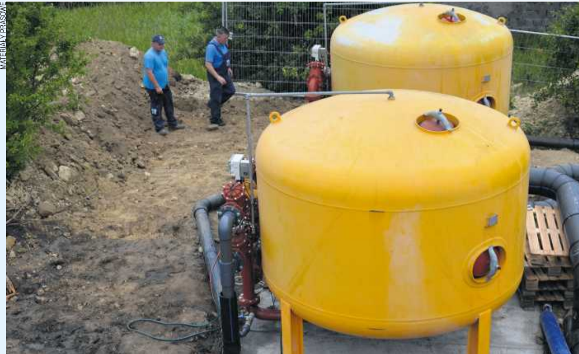
Zakończył się pierwszy etap modernizacji wodociągu w Dąbrowie Górniczej
