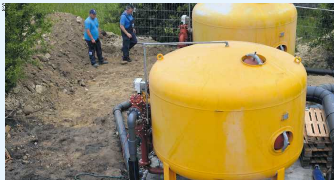
Przebudowa wodociągu pochłonie ok. 10 mln zł
