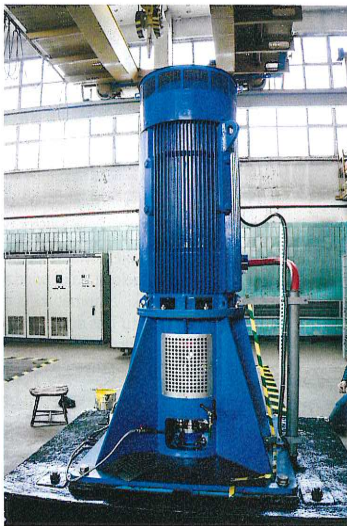
FOT. 4 Modernizacji poddane zostały również układy pompowe na Zakładzie Uzdatniania Wody w Goczałkowicach
