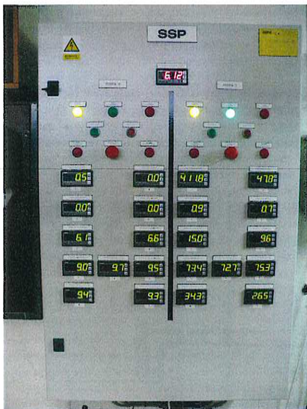
FOT. 3 Zamontowane obecnie nowe agregaty umożliwią regulację wydajności pomp w zależności od zapotrzebowania na wodę. Dzięki temu zwiększy się bezpieczeństwo dostaw, zmniejszy ryzyko awarii i znacznie ograniczone zostaną koszty energii
