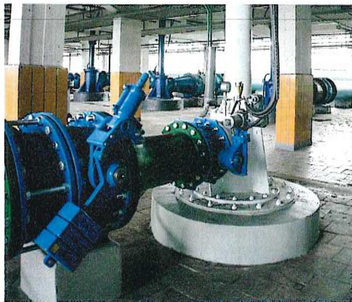
FOT. 5 W Goczałkowicach zastosowano dwie nowe pionowe pompy diagonalne
