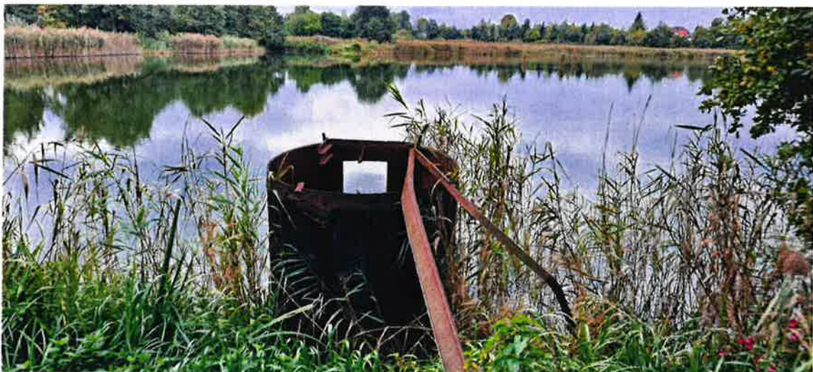
Zdjęcie nr 2.3. Widok na studnię zastawkową (MNICH).
