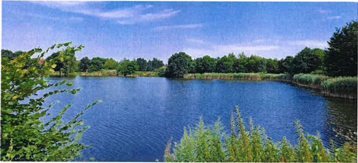
Zdjęcie nr 2.1. Widok na skarpe zachodnią.
