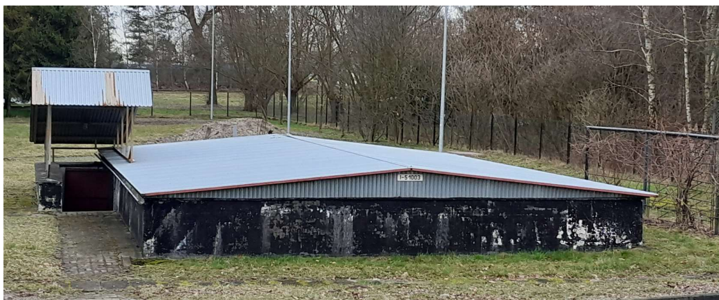
fot 1. Budynek komory uderzeń
