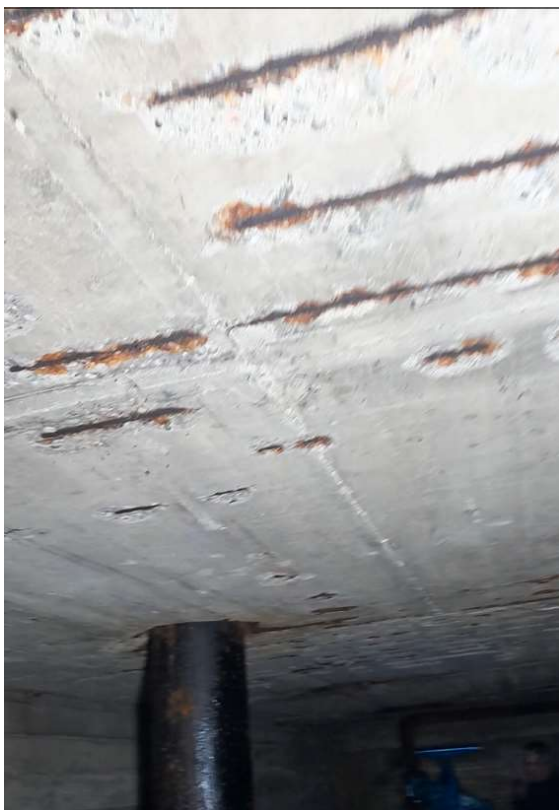
fot 6 i 7. Uszkodzenia stropu pośredniego budynku w poziomie -1.
