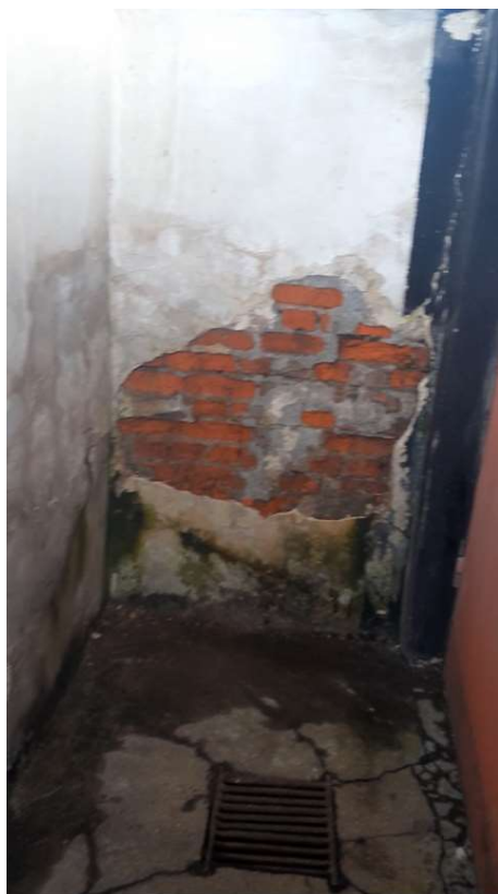
fot 4 i 5. Uszkodzenia ścian schodów budynku
