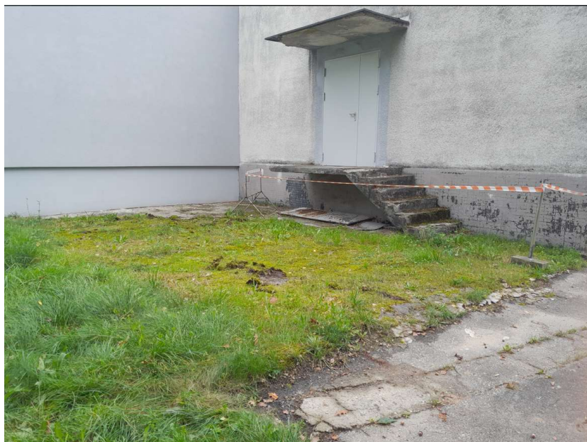
fot 9. Schody i zadaszenie (strop nad wjazdem do części elektrycznej)
