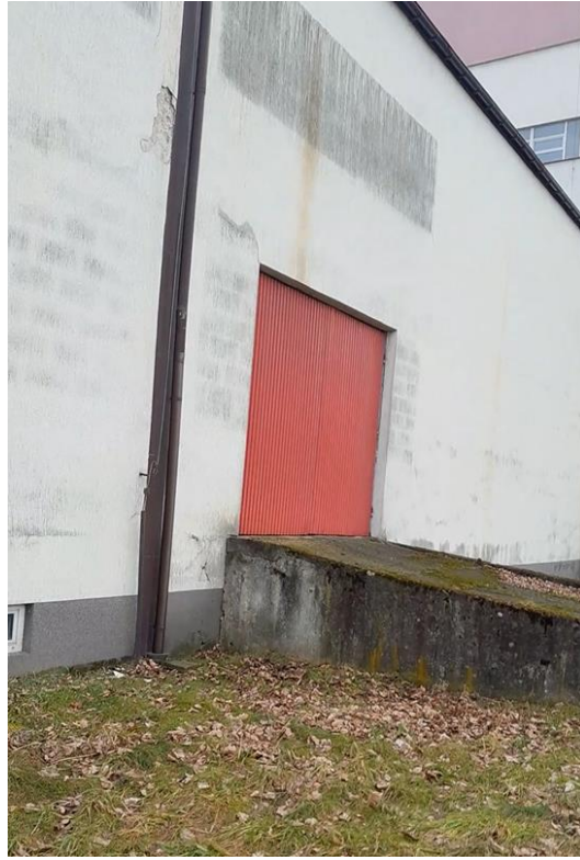
fot 4. Budynek Pompowni GO-CZA_I – rampa podjazdowa
