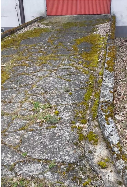
fot 3. Budynek Pompowni GO-CZA_I – rampa podjazdowa
