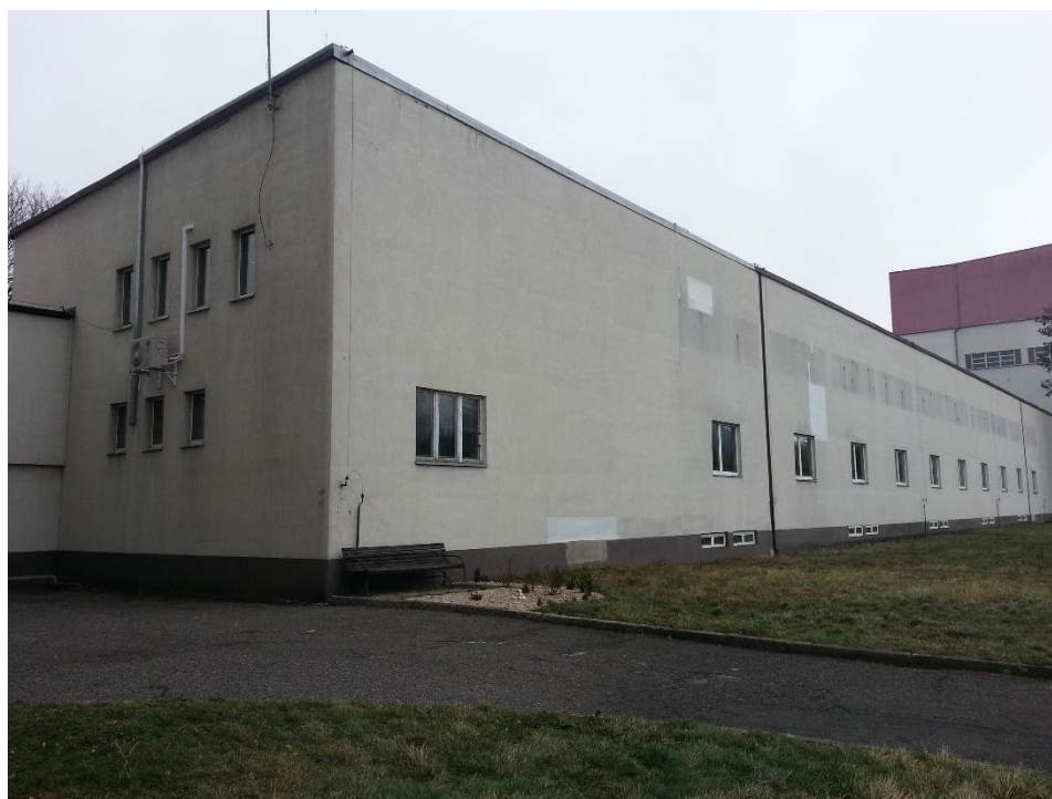
fot 2. Budynek Pompowni GO-CZA_I
