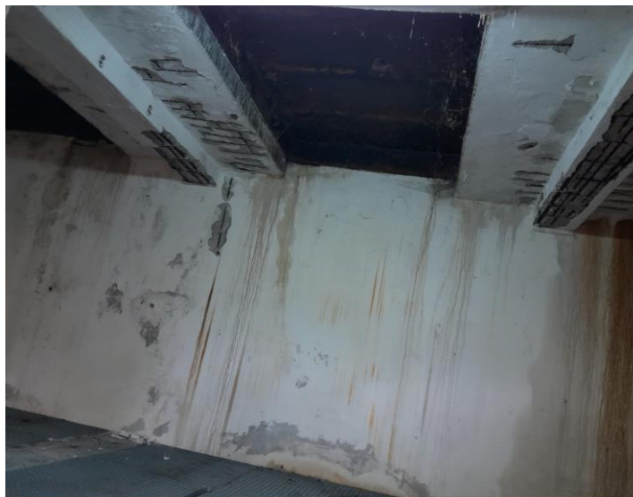
fot 4. Strop nad komorami aparatów przeciwuderzeniowych (podziemie)
