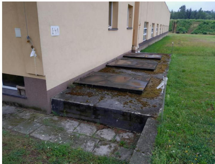
fot 1. Strop nad komorami aparatów przeciwuderzeniowych
