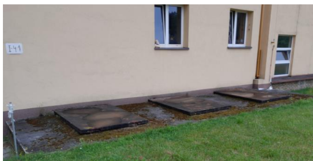
fot 2. Strop nad komorami aparatów przeciwuderzeniowych
